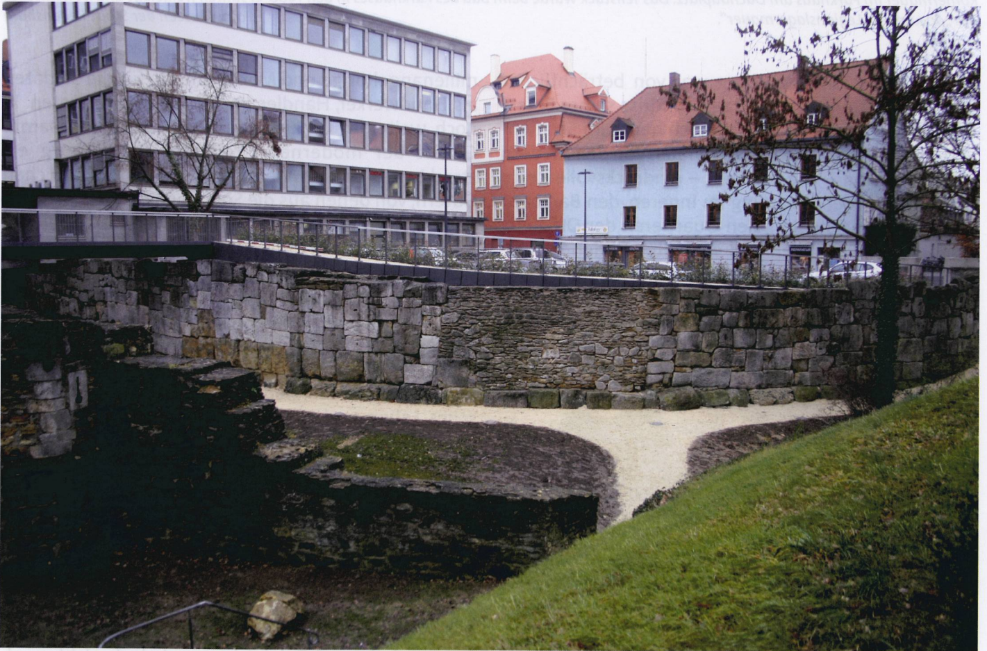
Die Süd-Ost-Ecke des römischen Legionslagers am Ernst-Reuter-Platz. Gut zu erkennen ist der Unterschied der römischen Mauertechnik in Großquadern und der Ausbesserungen und Ergänzungen durch kleinteiliges Mauerwerk in mittelalterlicher Zeit.
