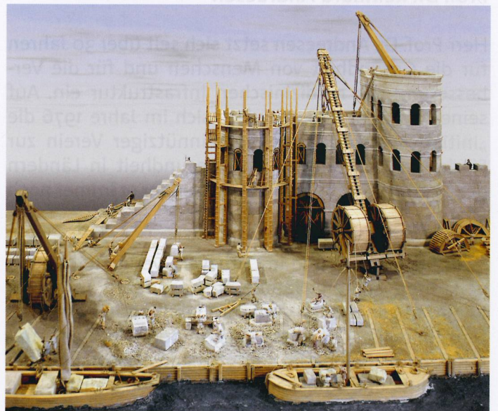
Wie die Porta Praetoria in ihrer Bauphase ausgesehen hat und wie die Römer beim Bauen mit der für sie typischen Mauertechnik in Großquadern vorgegangen sind, zeigt ein Modell der Baustelle in der Römer-Abteilung im Historischen Museum Regensburg.
