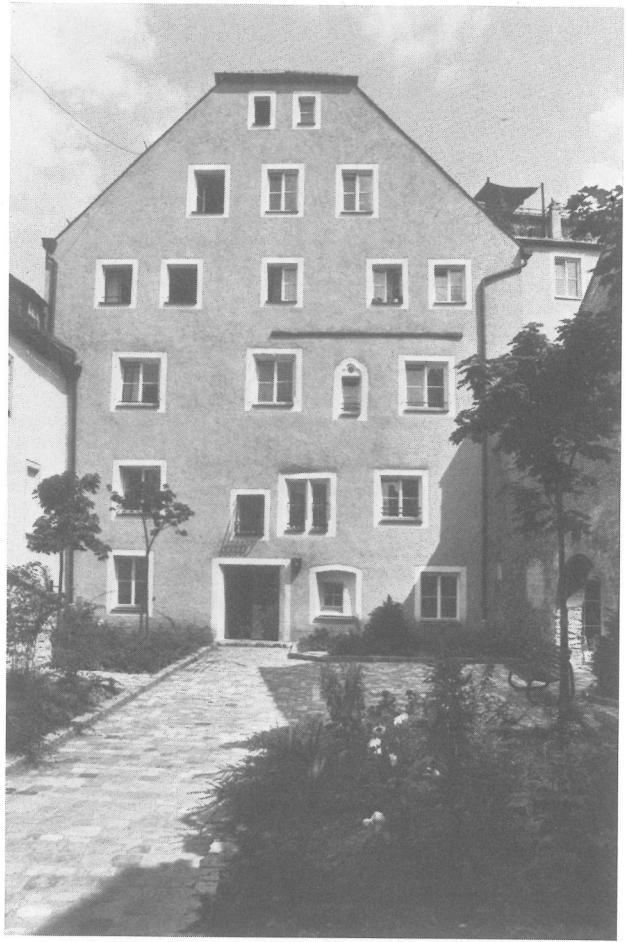
Wohnhof und rückwärtige Fassade des sanierten Wohnhauses Am Römling 2.
