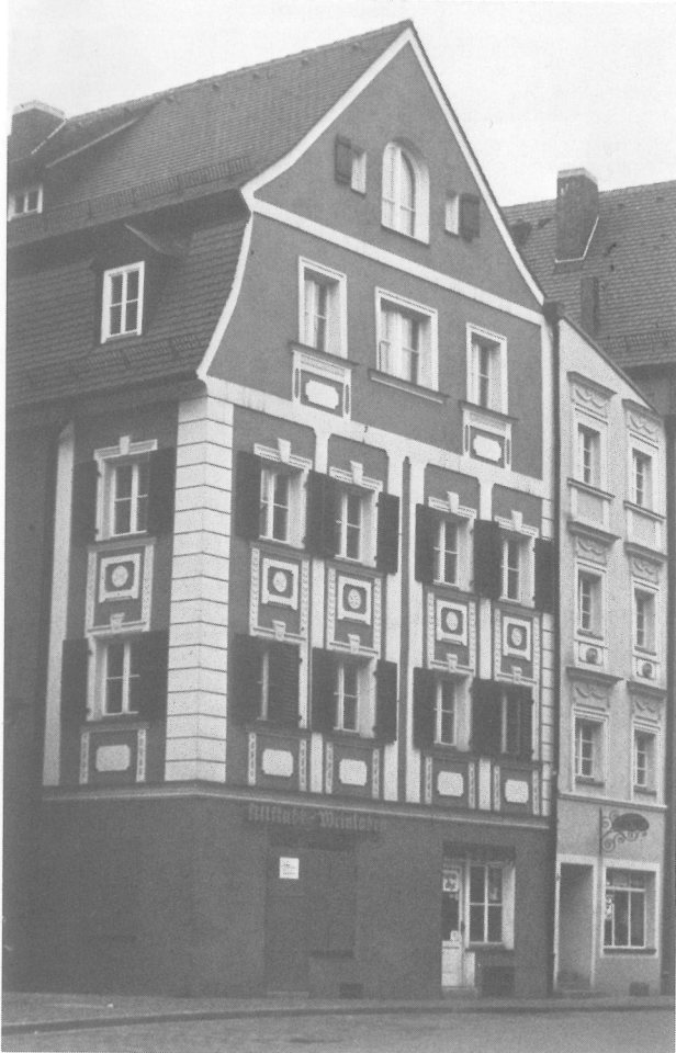
Die von der Stadtbau GmbH sanierten Wohnhäuser Fischmarkt 12 und 14, jetzt umbenannt in Silberne Kranzgasse 1.
