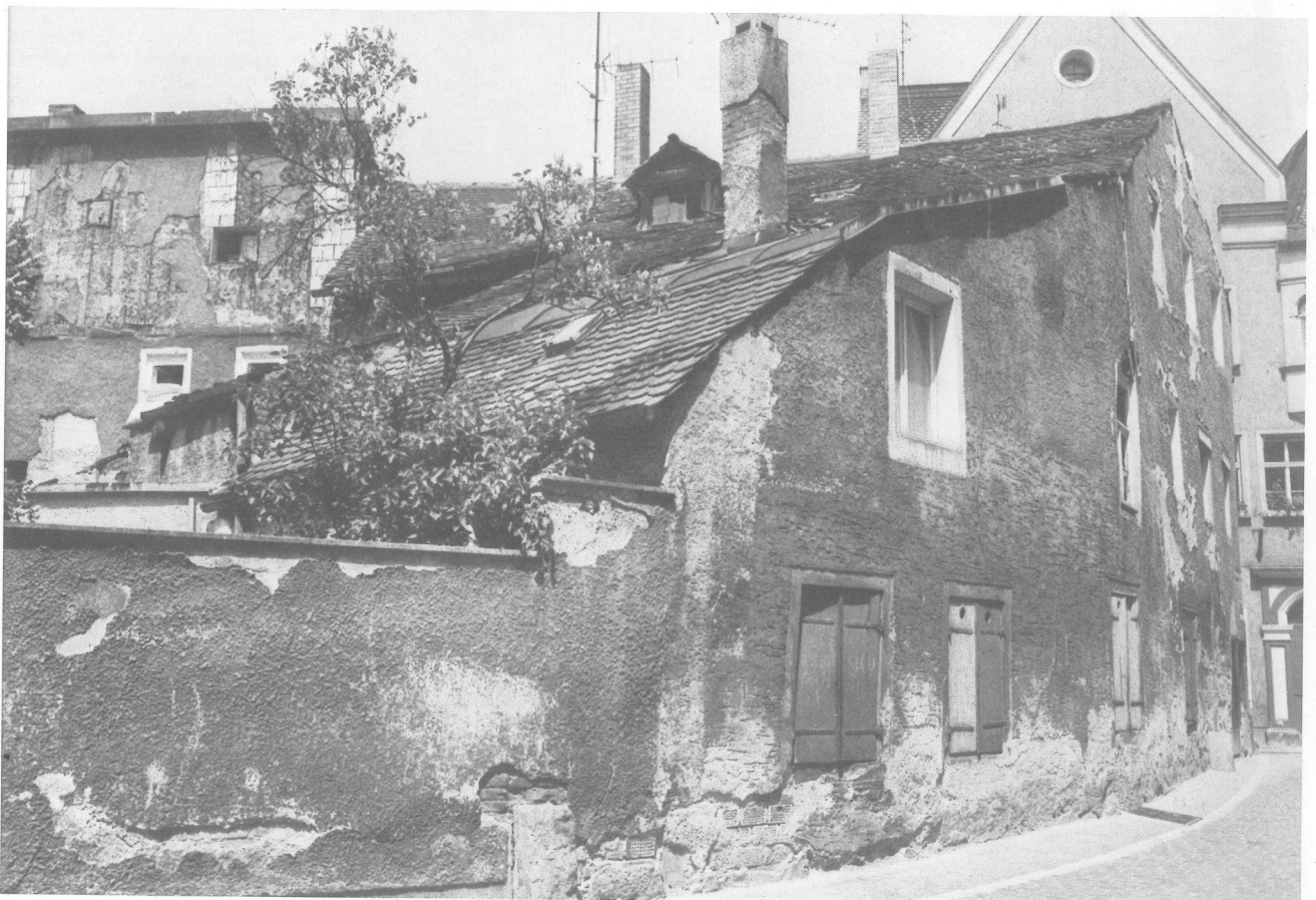
Wohnhäuser am Roten-Lilien-Winkel vor der Sanierung
